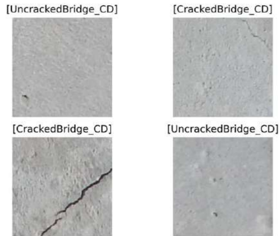
コンクリートのひび割れ
